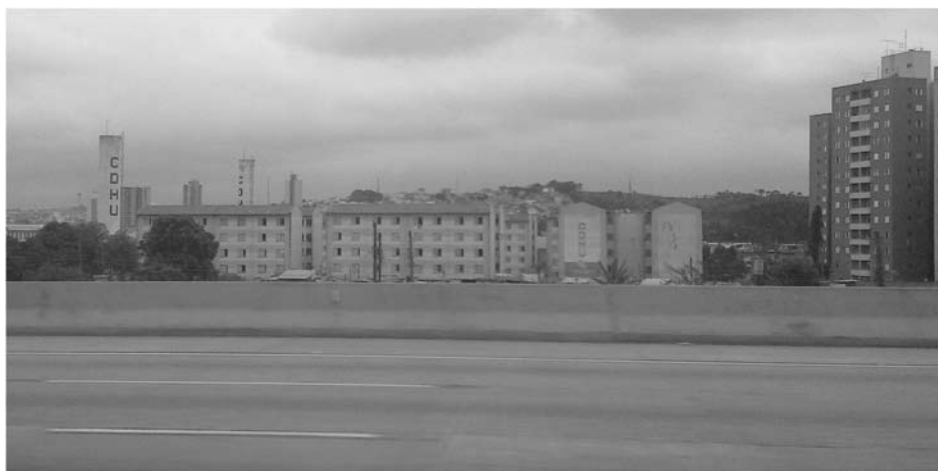
Figura 1.2 Prédios CDHU, no km 19 da Rodovia Castelo Branco, próximo ao acesso a Osasco-SP.
